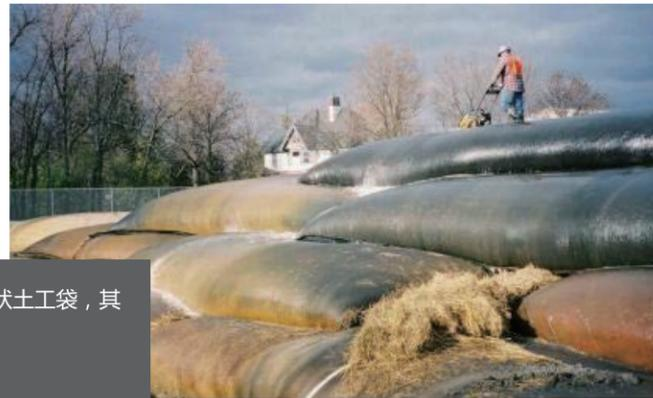
是一种由聚丙烯纱线编织而成的、具有过滤结构的管状土工袋，其特点为强度高、透水过滤性能好、可长期抗紫外线。
